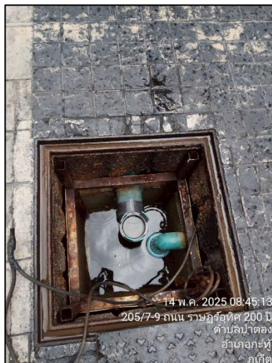
รูปภาพที่ 2.24 การชุดลอกตะกอนในบ่อพักน้ำ
