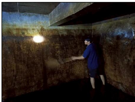
รูปภาพที่ 2.38 การล้างถังเก็บน้ำ
